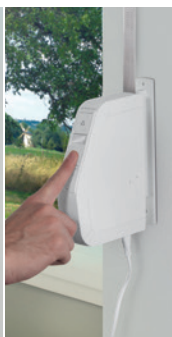
3. Gurtband einziehen und Schwenkwickler einrasten
