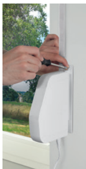
1. Manuellen Gurtwickler demontieren
